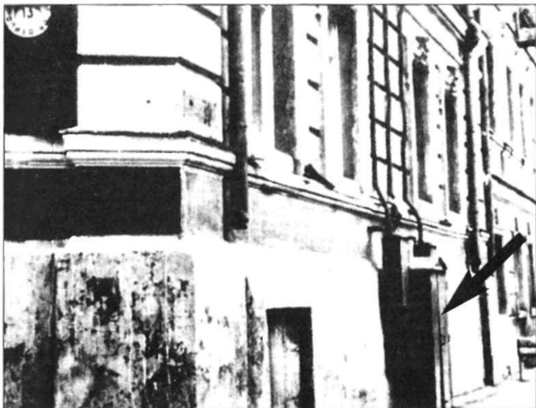
Металлический ящик у стены дома № 13 по ул. Палиха — место тайниковой закладки
